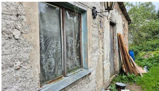
Būves (dzīvojamā ēka) ar kadastra apzīmējumu 0900 017 0018 001 - vērtējamā daļa
